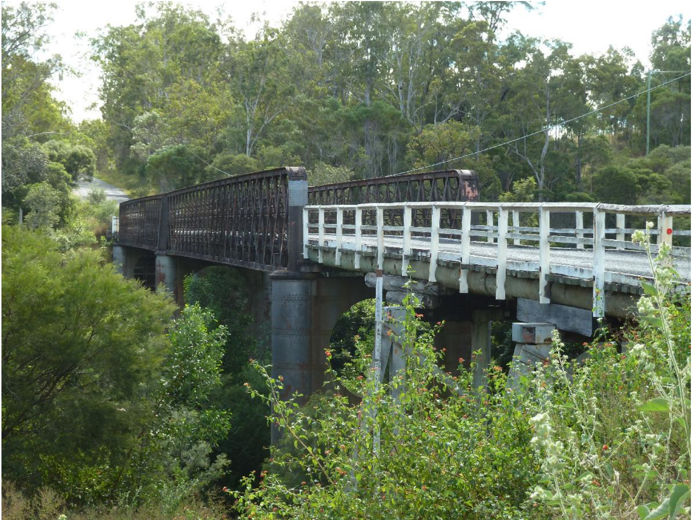
Caption: Bawden Bridge.
